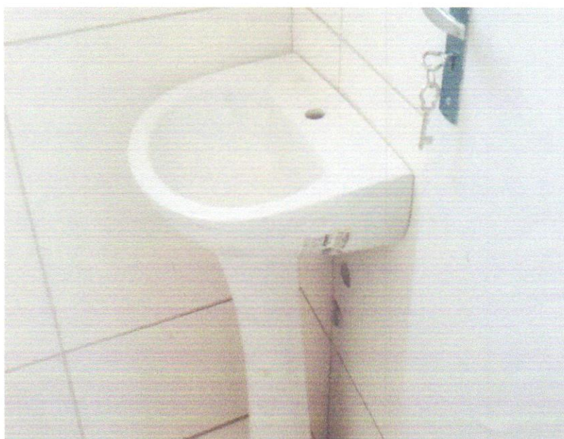
FOTO 04 – LAVATÓRIO LOUÇA BRANCA COM COLUNA, 44 X 35,5 CM, PADRÃO POPULAR, INCLUSO SIFÃO FLEXÍVEL EM PVC, VÁLVULA E ENGATE FLEXÍVEL 30CM EM PLÁSTICO E COM TORNEIRA CROMADA PADRÃO POPULAR - FORNECIMENTO E INSTALAÇÃO. AF_01/2020
