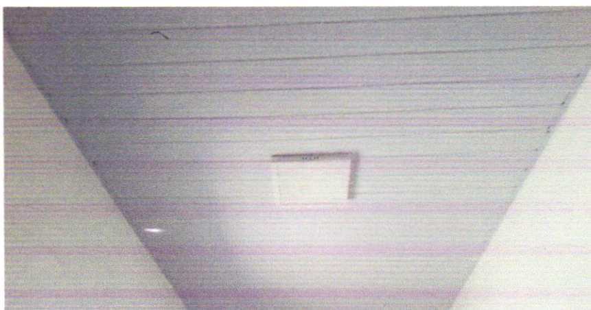
FOTO 01 – Forro de pvc, em réguas de 10 ou 20 cín, aplicado, inclusive estrutura para fixação (perfis em PVC) marca Araforros ou similar, instalado - Rev 06-10/2021
